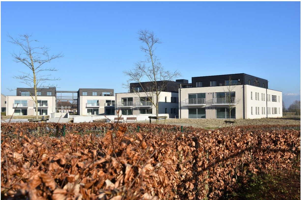
Seniorenappartementen te Rumbeke, Knokuilstraat
