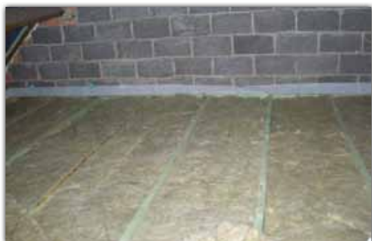
Een voorbeeld van vloerisolatie op een zolderverdieping.
